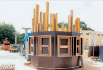
Schalung des Fertigteiltes der Turmlaterne vor Ort
