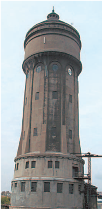
Vor der Sanierung, Südwestansicht
